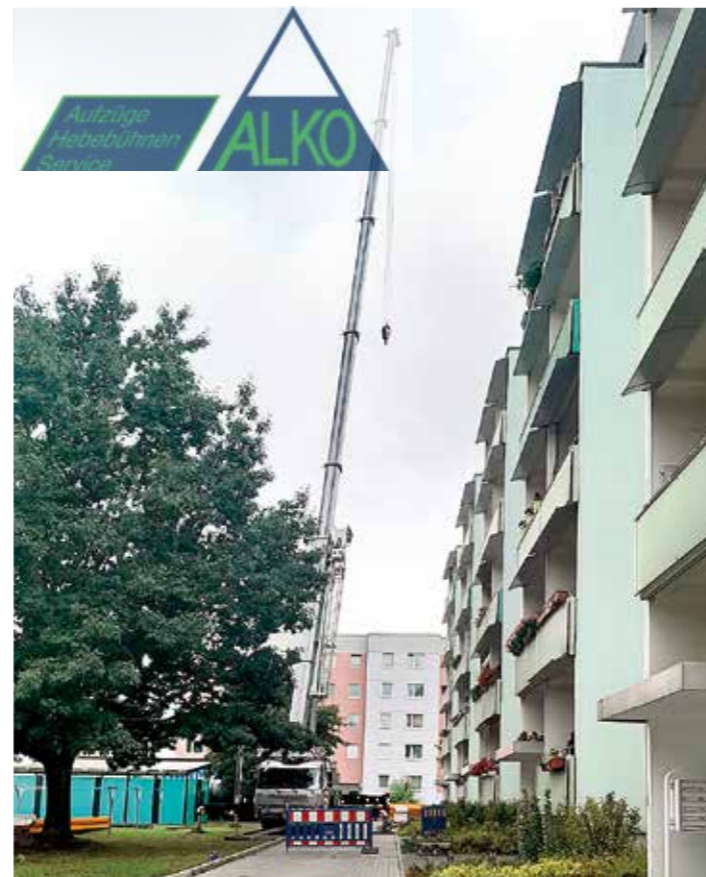
Aufzugseinbau in der Heinrich-von-Kleist-Straße 10 bis 14
