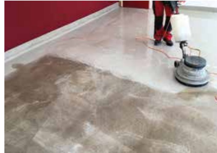
Nass-Grundreinigung eines Kunststoffbodens
