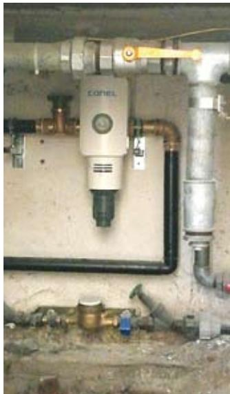
Filter ausgewechselt werden. Die Feststellung, ob Filter erneuerungsbedürftig sind, erfolgt in der Regel im Rahmen der jährlichen Wartung der Heizungsanlagen bzw. bei den Begehungen im Rahmen der Verkehrssicherungspflichten.
